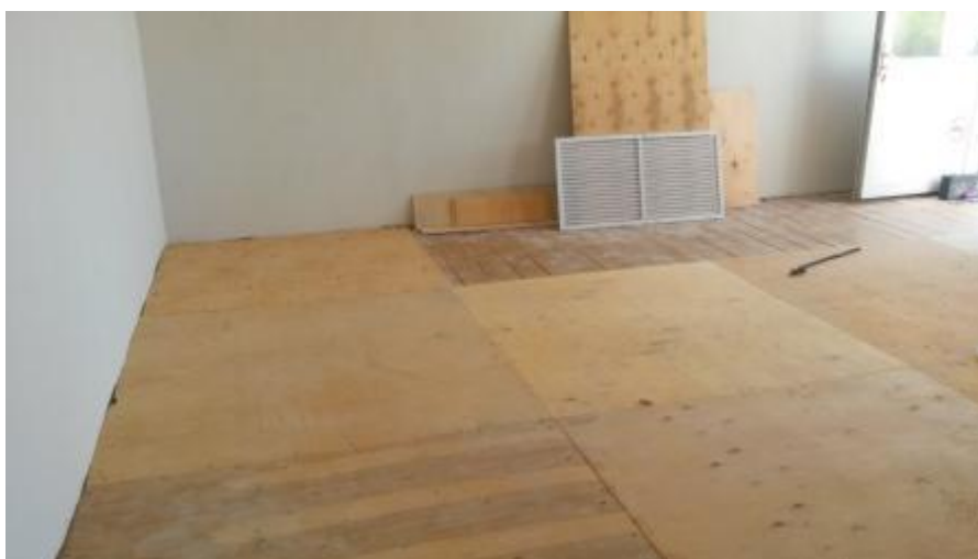
Раздел 6. Отопление: установка радиаторов чугунных
