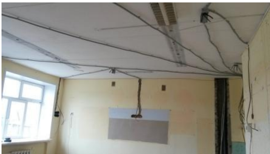
Раздел 2. Потолки: устройство подвесных потолков
