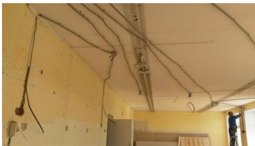
Раздел 7. Электроосвещение: демонтаж светильников, скрытой проводки, прокладка кабелей, установка розеток и светильников
