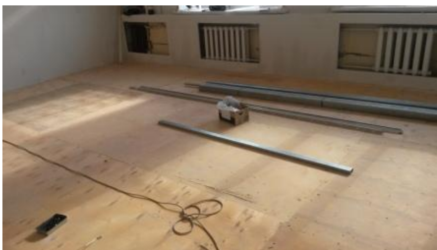
Раздел 6 Отопление: установка чугунных радиаторов
