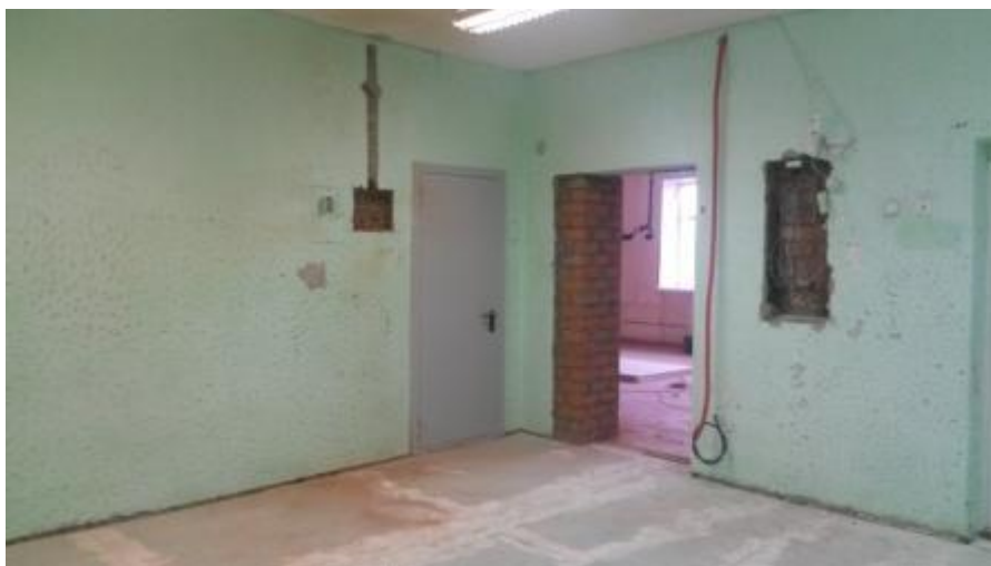
Раздел 4. Окна: демонтаж окна
